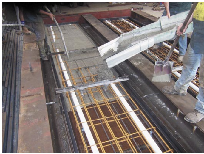
Right: Concrete pour in progress.
